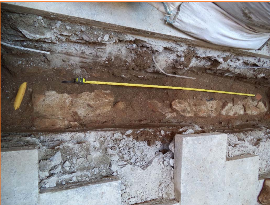
Foto 16. Mur UE4, tram 14.
