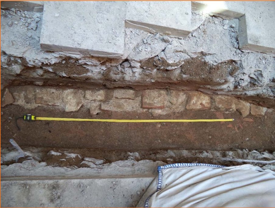
Foto 15. Mur UE4, tram 13.
